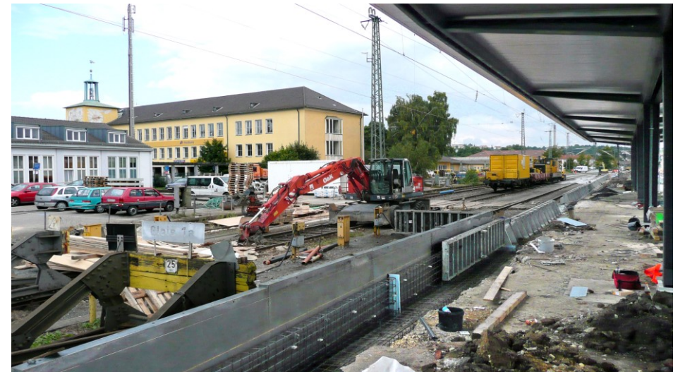
Der Inselbahnsteig zwischen den Gleisen 1 und 25 wurde nicht rechtzeitig fertig. Oben 14.9. und unten 10.9.
